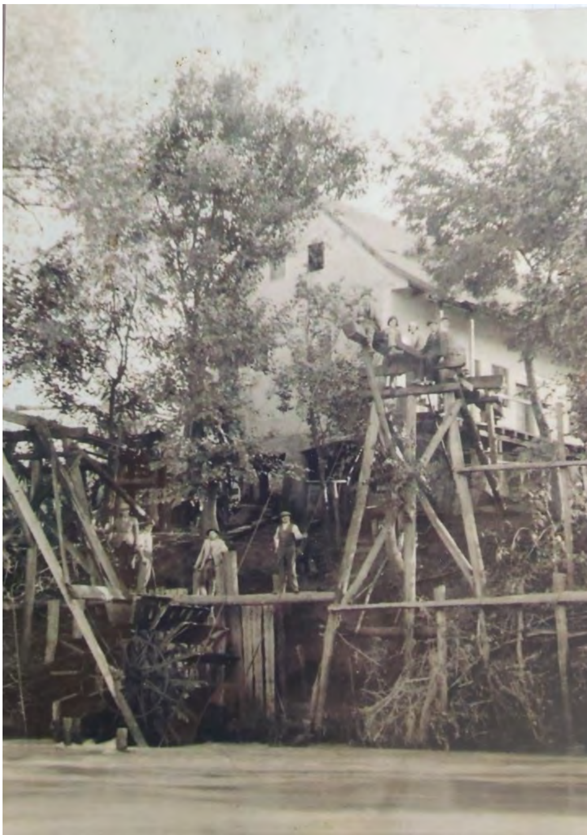
Fig. 5 Moară de apă cu aducțiune inferioară din Ineu, județul Arad (colecția Nicu Pinteș, Ineu)
