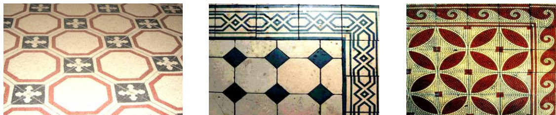
Fig. 6. Plăci pentru pavaje ornamentale din marmură și ciment din câteva imobile orădene, în ordine, de la stânga spre dreapta: Universitatea Creștină Partium (holul central și casa scârilor), Biserica Mănăstirii Ursulinelor (pridvorul), Palatul Stern (culoar și casa scârilor) - Sursa: Colecția Ronald Hochhauser
