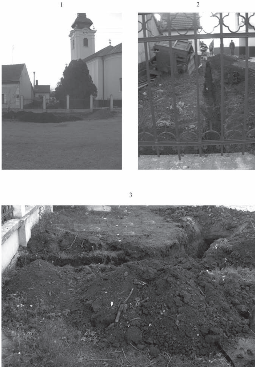
Pl. III. Cefa, biserica ortodoxă, 2008. Excavații pentru conducta de apă a bisericii. 1. Amplasamentul lucrărilor. 2. Excavații în curtea bisericii. 3. Excavații în strada Ungurească.
