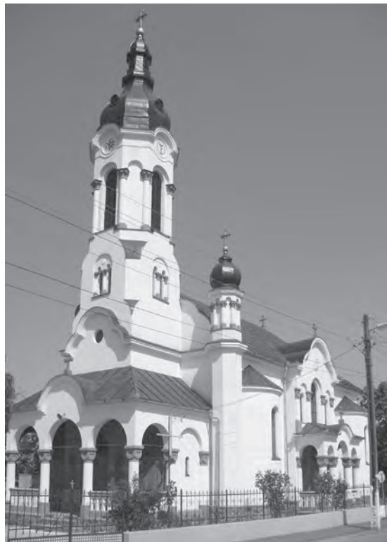
Fig. 9. Biserica ortodoxă cu hramul Adormirea Maicii Domnului din Mărțihaz. Biserica a fost construită între anii 1936-1939, pe baza unui proiect tip semnat de arh. Francisc Sztarill. Aceași variantă de proiect a fost folosită pentru bisericile din: Petid, Alparea, Lăzăreni, Cheșa, Râpa, Rieni.
